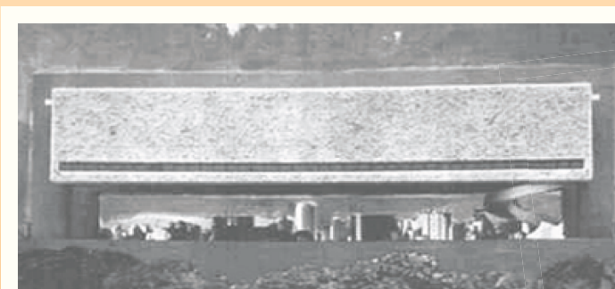
Museu de Arte de São Paulo – MASP. Versão original opaca, não construída.
